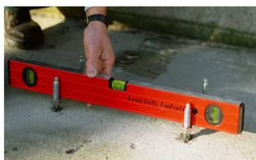
1. Vissez les écrous de réglage sur leurs ancrages au sol et placez les rondelles sur les écrous.
