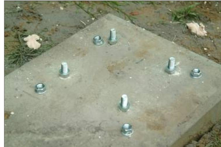
Système écrou/contre-écrou pour mettre de niveau les poteaux
