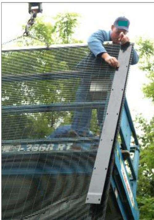
Fixer temporairement grâce aux boulons pendant que la grue maintient le panneau en position
