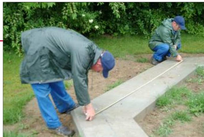
Indiquer précisément le centre des angles et le centre des poteaux d'extrémité
