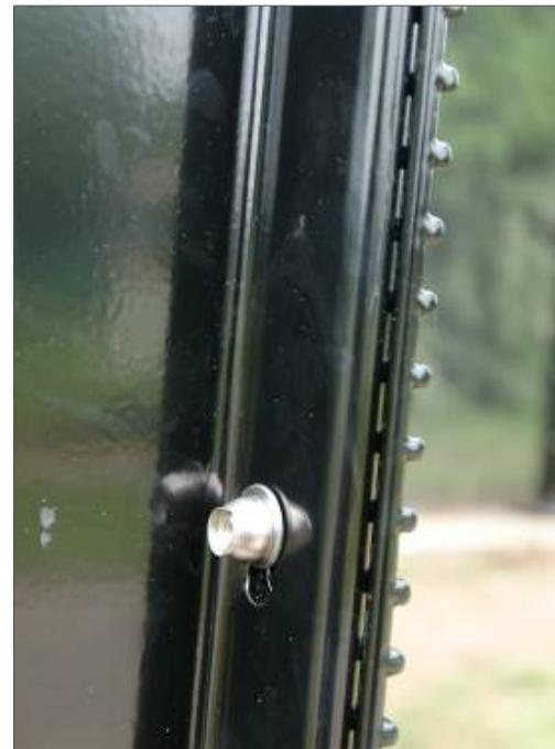
Sécuriser avec 4 boulons en haut du 2ème et du 3ème poteau en incluant le capuchon et le profil de jonction
