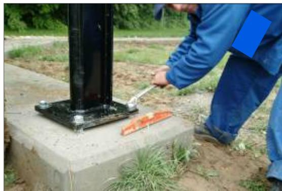
Mettre de niveau grâce au système écrou/contre écrou
