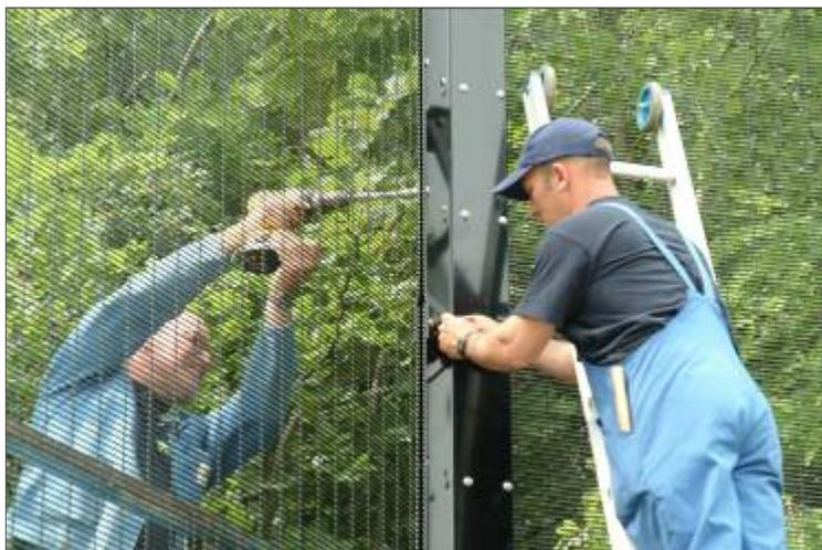
Enfin sécuriser le bas de la clôture avec les vis et écrous autocassants
