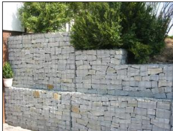
Gabione im Verbund (Quelle: Fa. Eiko)
